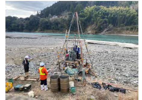
地質調査の状況 (R5.1.26) 【球磨村渡地区(引堤)】
