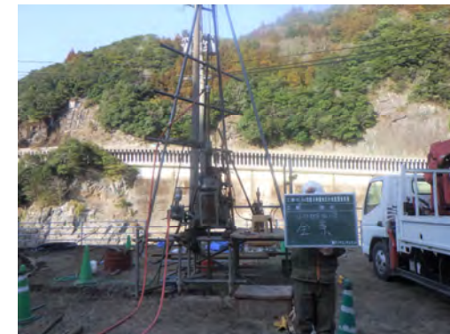
地質調査状況 (R5.1.24) 【芦北町小口地区】
