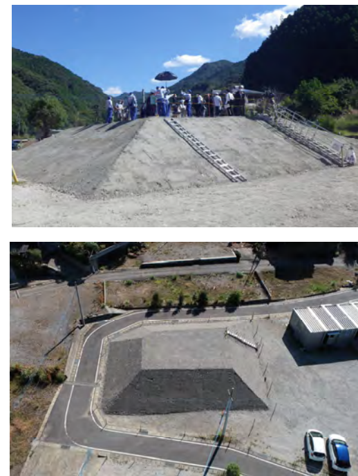
先行盛土完成
