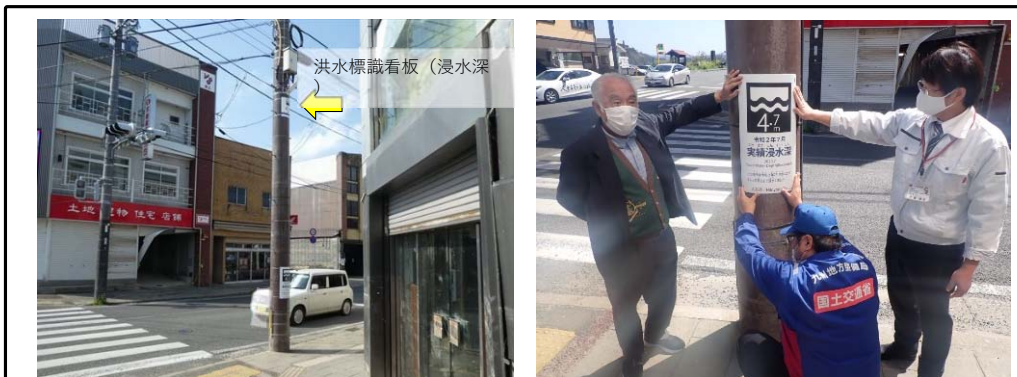
設置状況【R 3. 3. 23】
