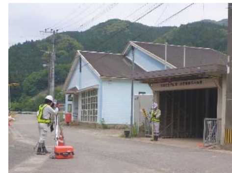
宅地かさ上げの設計・検討に向けた家屋敷高の測量状況 [球磨村]
