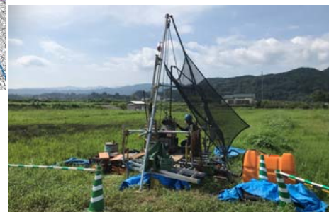
遊水地の設計・検討に向けた地質調査状況 [人吉市]
