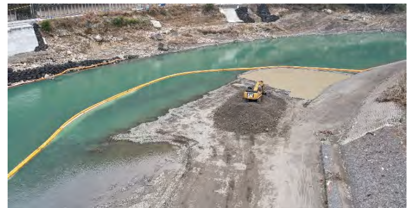
汚濁防止フェンスの設置状況
