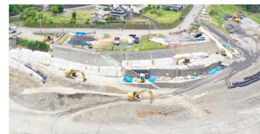
【芦北町告地区】 工事進捗状況5月末時点
