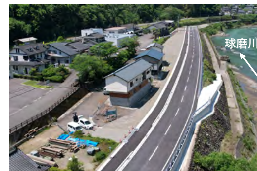
【球磨村友尻地区】 工事進捗状況5月末時点
