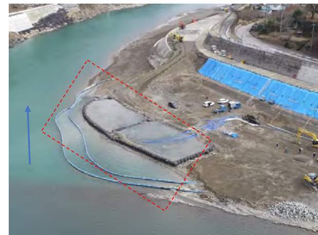
沈砂池設置状況
