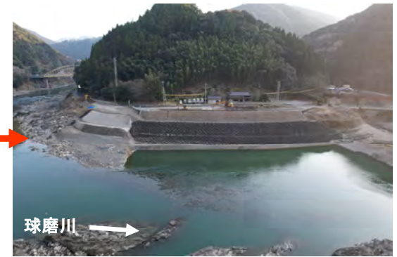
施工中 R8.3末時点
