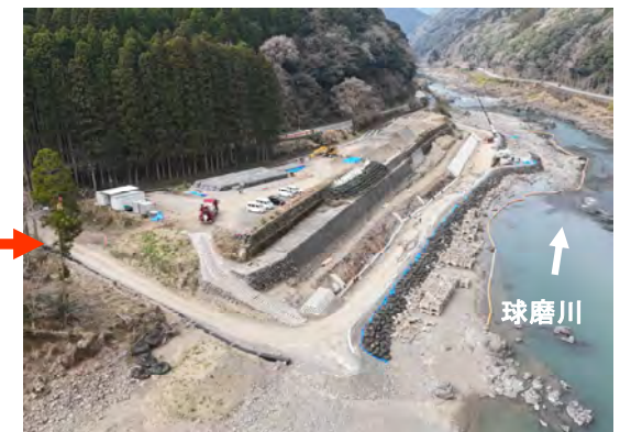
施工中 R8.3末時点
