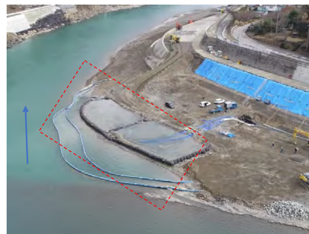
沈砂池設置状況
