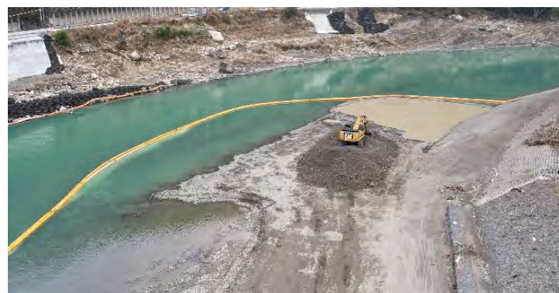
汚濁防止フェンスの設置状況
