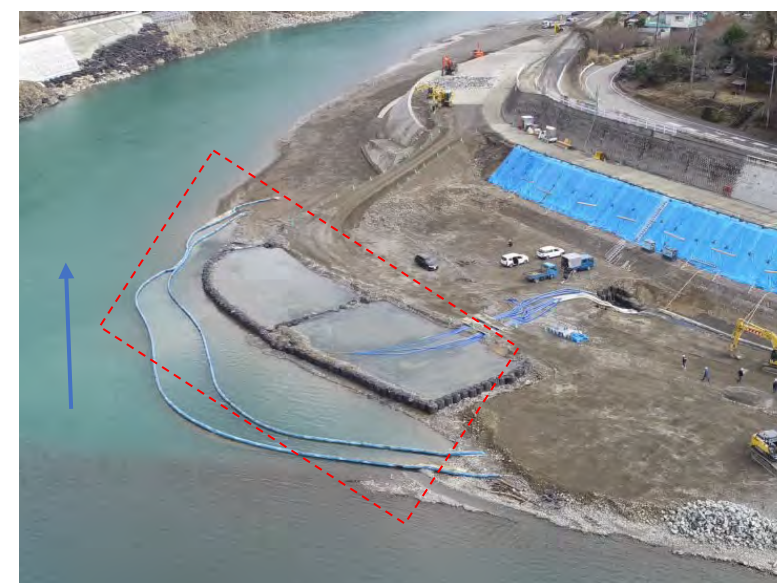
沈砂池設置状況
