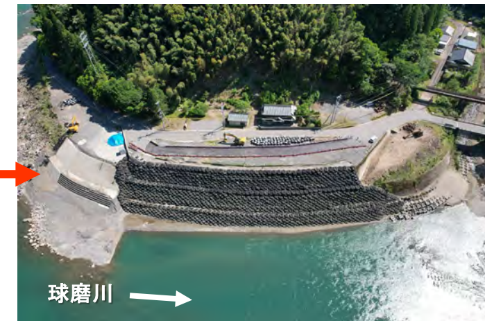
施工中 R8.5末時点
