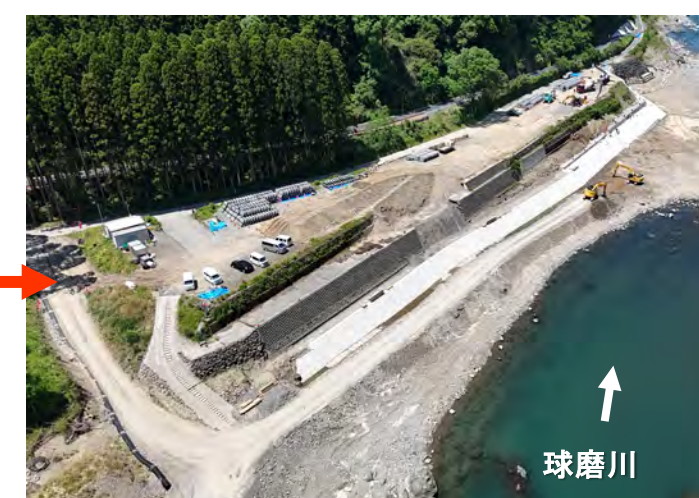
施工中 R8.5末時点
