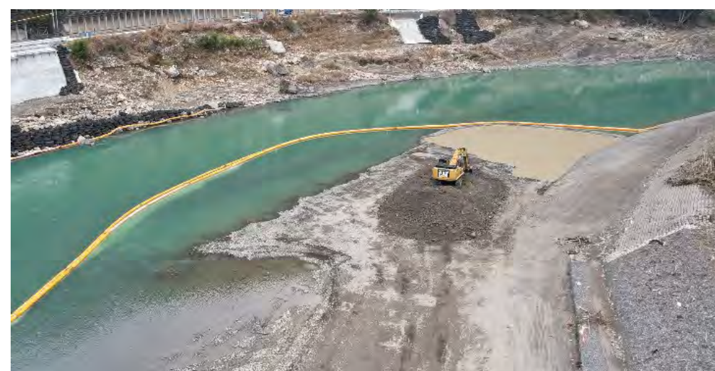
汚濁防止フェンスの設置状況
