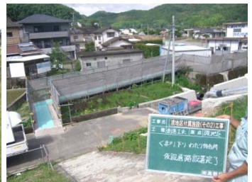
くま川下り渡舟場をご利用のお客様への配慮として仮設の設置、危険防止の為交通誘導員を配置しました
