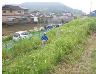
定期的に堤防部の除草を行いました。
