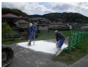
鳥インフルエンザ発生時にウイルス拡散防止の為、現場出入り口に消石灰の散布を実施しました。
