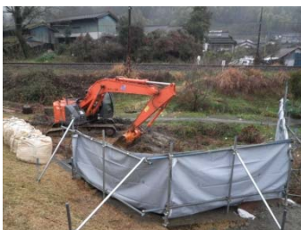
作業中に発生する騒音の低減対策として、防音シートを設置して作業を行いました。
