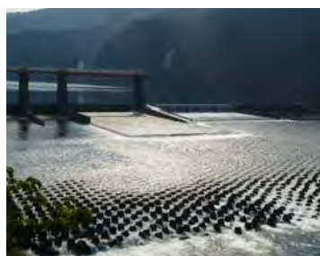
左岸側洪水吐ゲートからの放流
