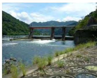
右岸側土砂吐ゲートからの放流
