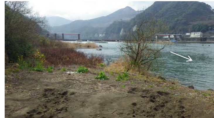
遙拝堰右岸下流の水際状況
