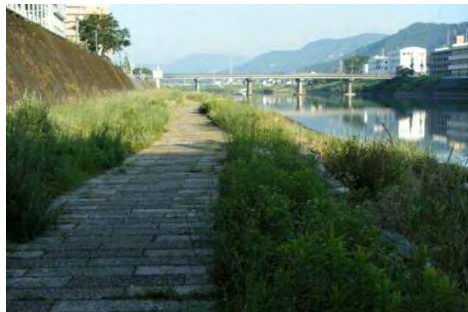
切石舗装の事例（五ヶ瀬川：本小路地区）
