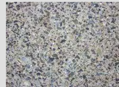
現場打ち（玉砂利舗装）
