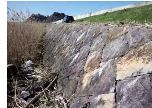
谷積の施工例(熊本:球磨川)
