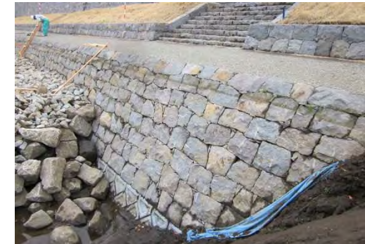
布積の施工例(熊本:白川)
