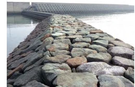
巨石による防波堤の施工例(熊本)
