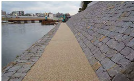
巻き天端仕上げと豆砂利舗装 （白川：子飼地区の事例）
