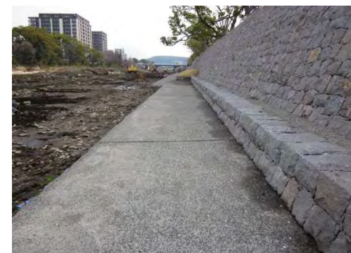
法尻(段差)の施工例(熊本:白川)
