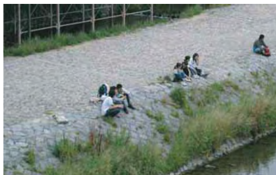
巻天端の施工例(京都:鴨川)
