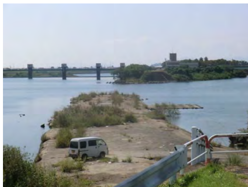
敷石(旧前川堰)
