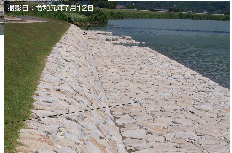
石畳みのような平らで低水護岸と一体的な構造となっている。
