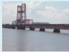
筑後川昇開橋
