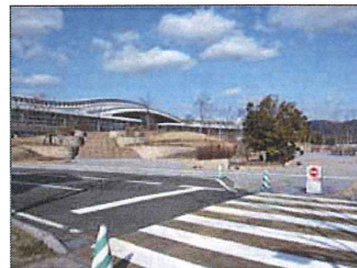
写真H：階段部
