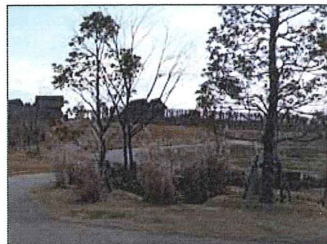
写真D：縦断勾配が7.8%の区間
