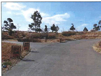
写真A: 迂回ルートへの誘導サインが必要
