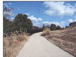
写真I：縦断勾配が9.5%の区間
