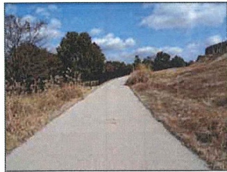
写真1: 北墳丘墓から既設のバス停までの園路。約9%の勾配となっており、移動障害を持つ利用者にとっては、移動しづらい状況である。
