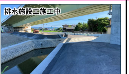
受注者：(株)中野建設 現場代理人：弥永 凌
