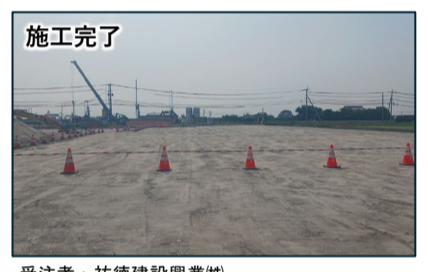
受注者：祐徳建設興業(株) 現場代理人：松下 綜汰
