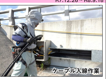
ケーブル入線作業
