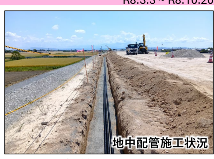
地中配管施工状況
