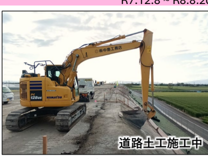
道路土工施工中
