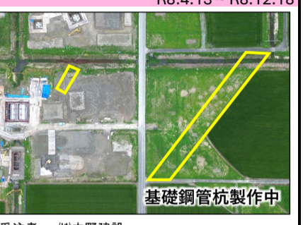
基礎鋼管杭製作中
