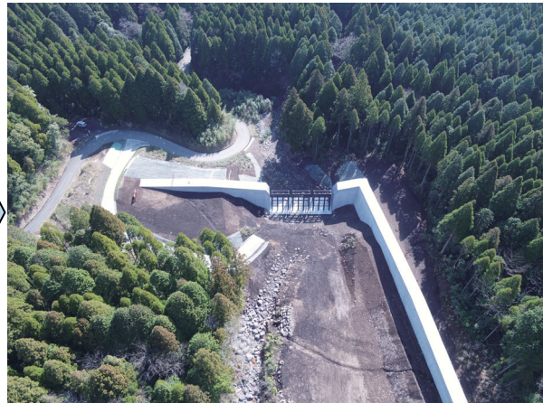
【完成（上流側より）】
