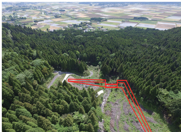
【着工前（上流側より）】
