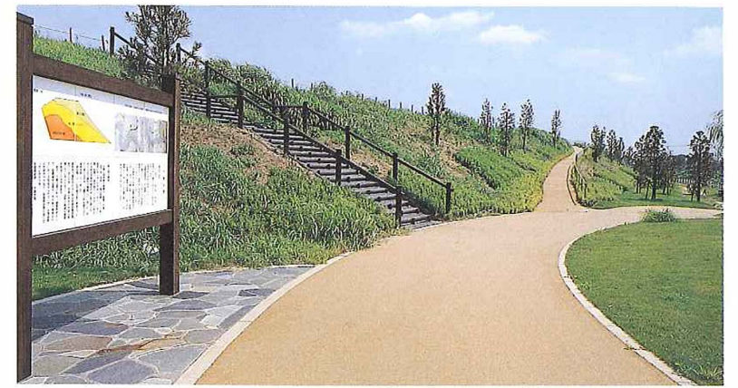
●現在は公園として整備されている千栗堤防跡
