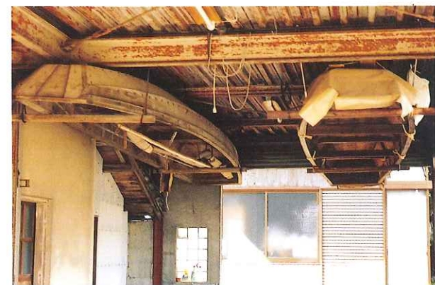
●天井から吊るされた舟
