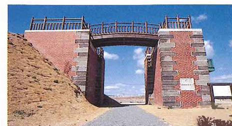
●埤水門（明治34年築造：千代田町）
