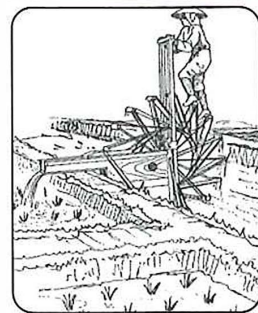
●クリークから水をくみ上げていた足踏み水車
