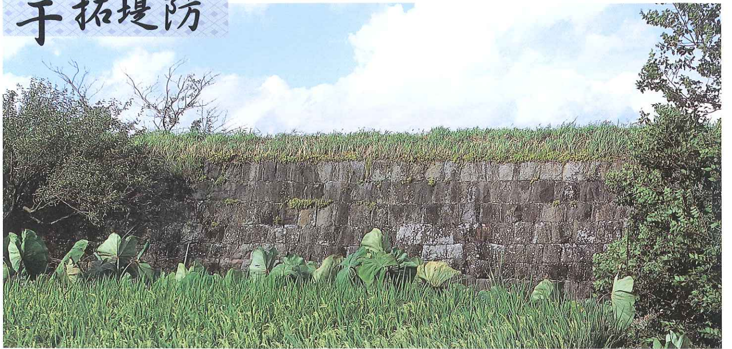
●石積みの干拓堤防
