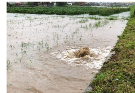
筑後川右岸39k600付近 川裏 自噴状況
