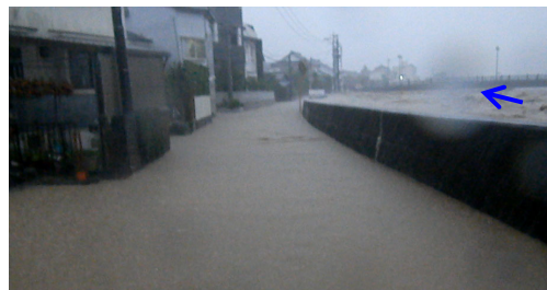
花月川左岸3k800付近
