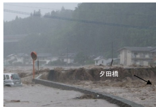
夕田橋 流木によるせき上げ 花月川4k600
