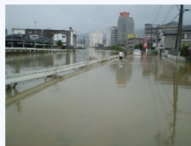
下弓削川左岸 浸水状況（H30年7月）
