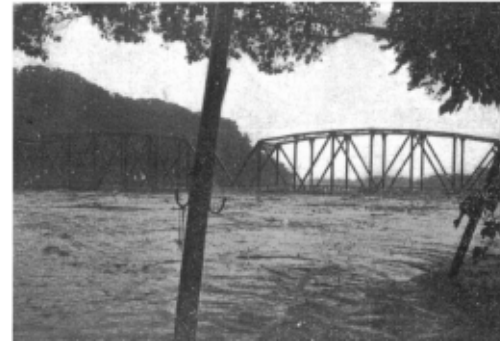
矢部川(船小屋地区)の氾濫状況
