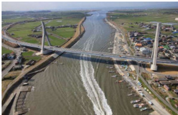
矢部川大橋 (有明海沿岸道路 平成21年3月開通)
