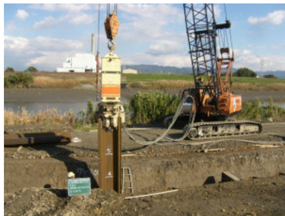
広幅鋼矢板の使用 (みやま市上庄地区)
