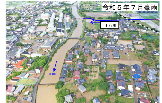
巨瀬川10k000付近の浸水状況
