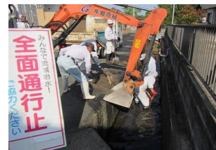
排水路の土砂撤去状況 (久留米市田主丸町)
