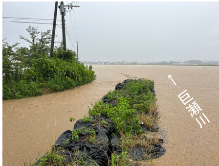
巨瀬川左岸7k200付近の越水状況
