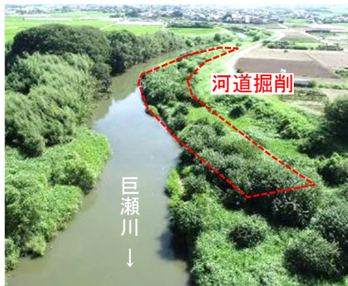
巨瀬川2k800付近
