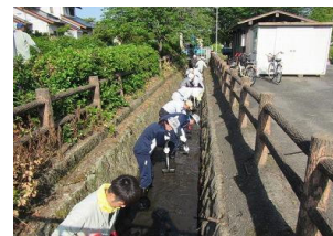
排水路の土砂撤去状況 (久留米市田主丸町)
