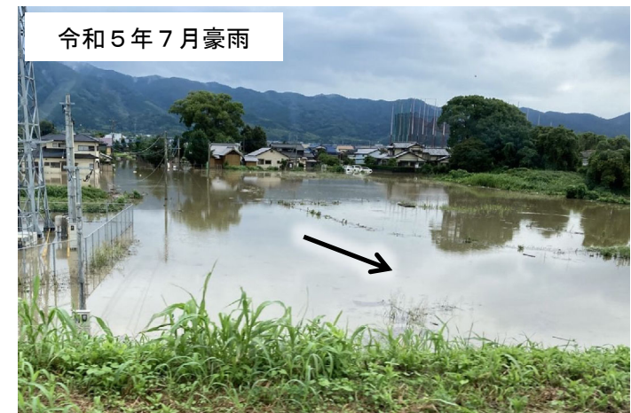
藤町川の溢水状況
