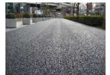
透水性舗装施工例
