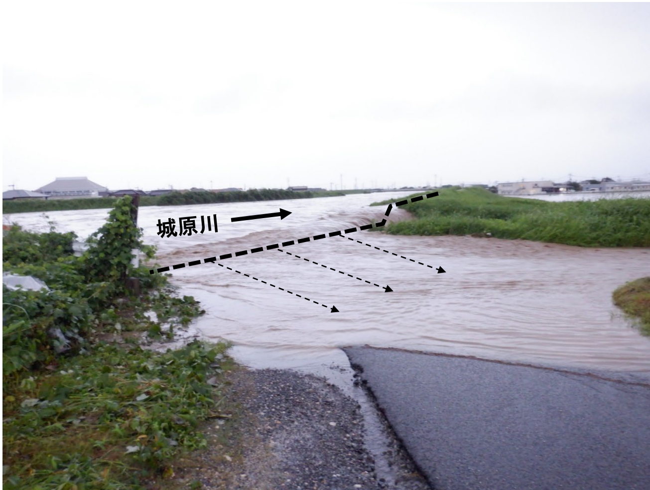
8k600右岸ふるさと大橋下流(9号野越し) (令和5年7月10日 8時00分時点)
