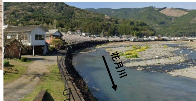
【平常時】 7k800右岸岡本橋上流
