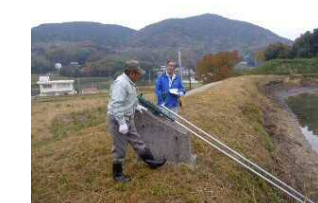
ため池の現地パトロール
