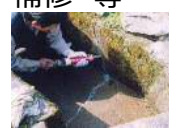
水路のひび割れ補修
