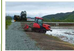
農機の旋回を容易にし、作業効率を向上させるターン農道の整備
