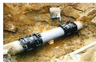
漏水防止のための整備
