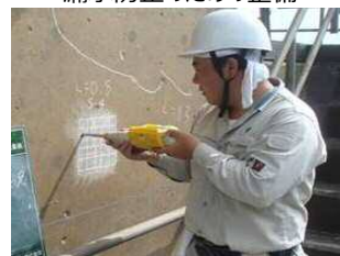
老朽化した施設の機能診断
