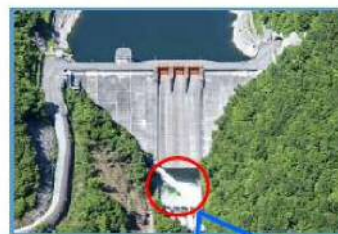
放流設備からの放流状況
