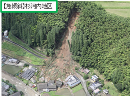
【急傾斜】杉河内地区
