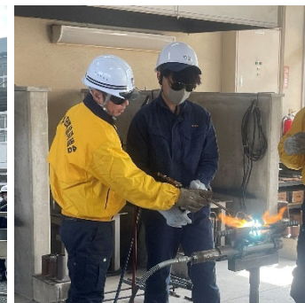
【鉄筋ガス圧接】
