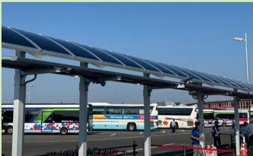
バス停の屋根に設置されたペロブスカイト太陽電池
