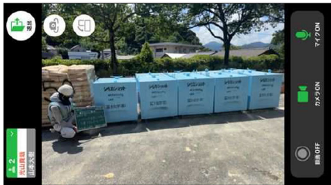
【立会状況（現場側） 地盤改良材確認】
