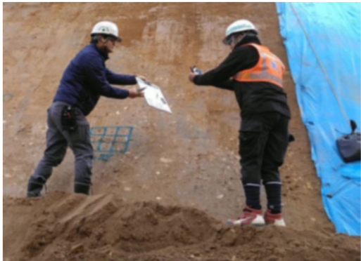
【立会状況（現場側）】
