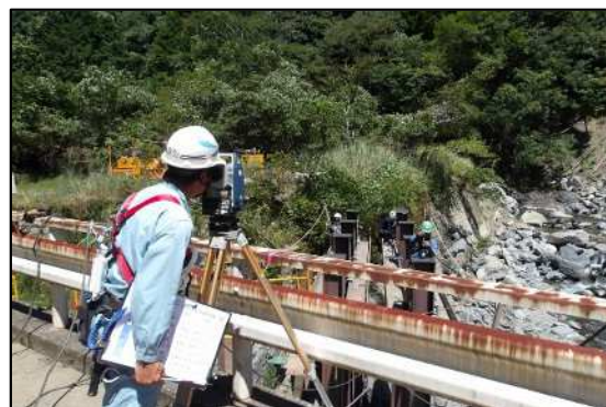
【現場確認状況（支持杭確認）】
