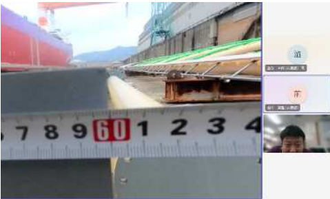
【出来形確認状況（近景）】
