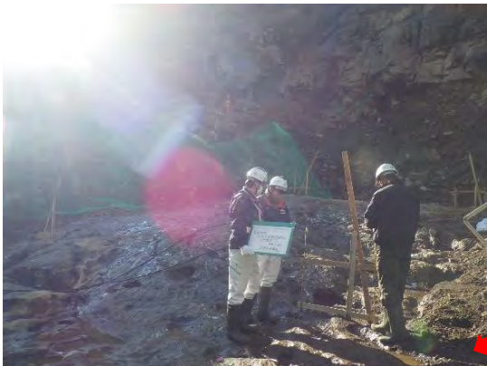
【立会状況（現場側）】
