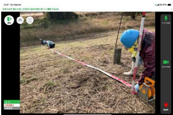
【立会状況（現場側）】
