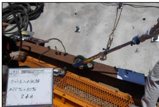
【現場確認状況（トルクレンチ確認）】
