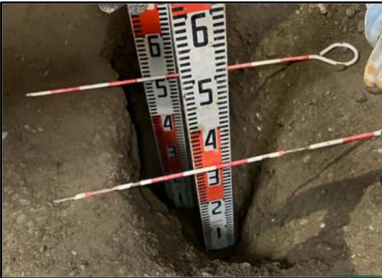
【立会状況（路盤出来形確認）】
