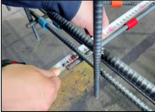
【立会状況（配筋確認；近接）】
