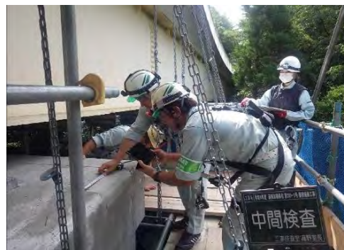
【立会状況（現場側）】
