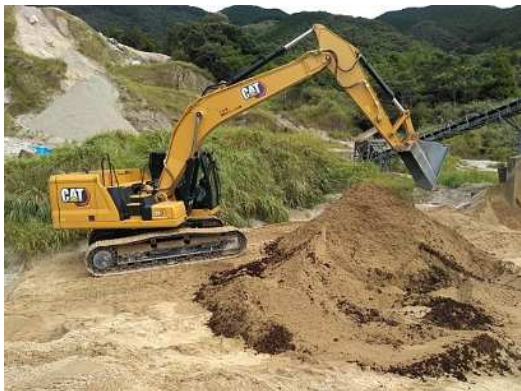
【立会状況（監督側）】
