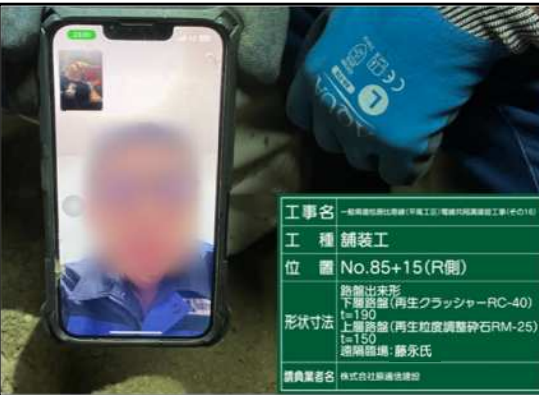
【立会状況（路盤出来形確認）】
