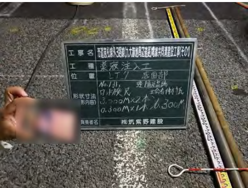
【立会状況（薬液注入ロット検尺）】
