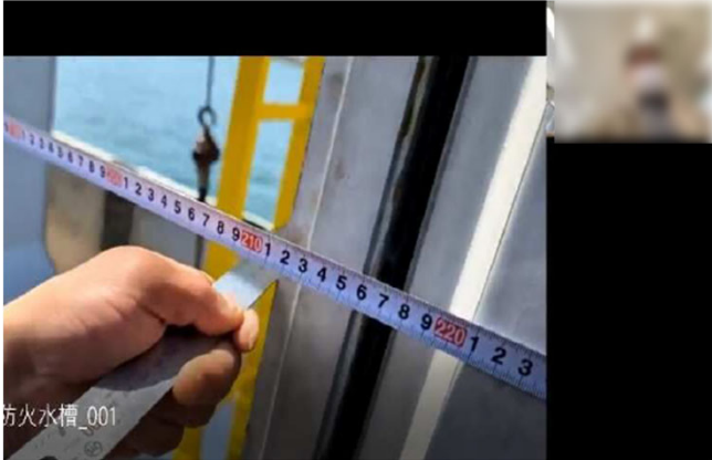
【近景撮影状況(防火水槽材料確認)】
