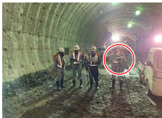
【会議用スピーカーの設置（現場側）】
