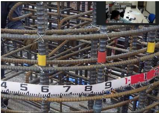
【立会状況（現場側）】
