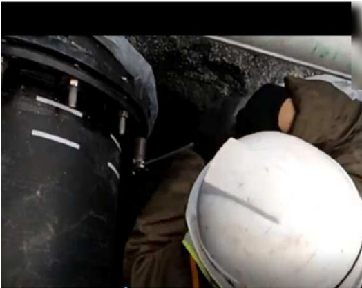
【立会状況（現場側） 締付トルク確認】
