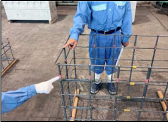
【立会状況（配筋確認）】
