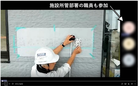
【立会状況（監督員側から見た画面）】
