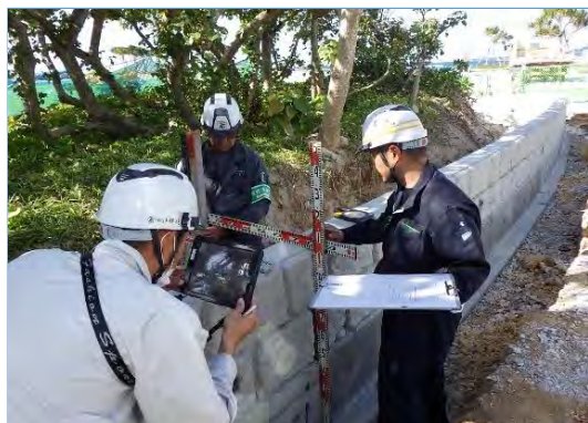
【立会状況（現場側）】
