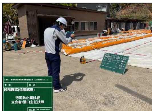
【立会状況（現場側）】
