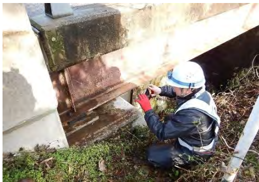
【立会状況（現場側）スマートフォンにて実施】
