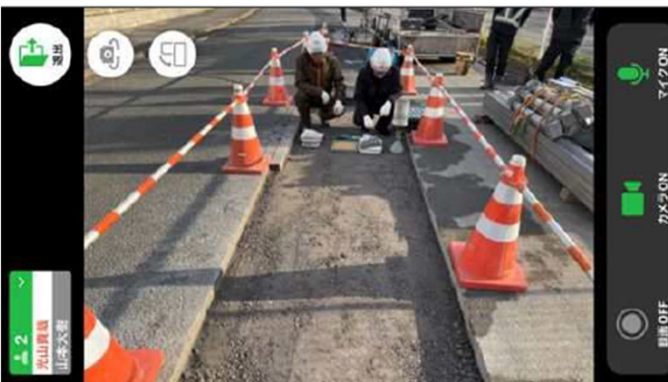
【立会状況（現場側） 路盤密度試験状況確認】
