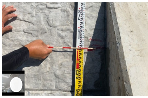
【遠隔臨場確認状況（床掘基準高確認）】
