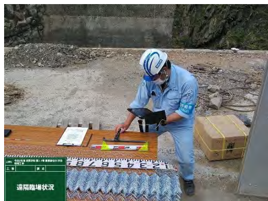
【立会状況（現場側）】
