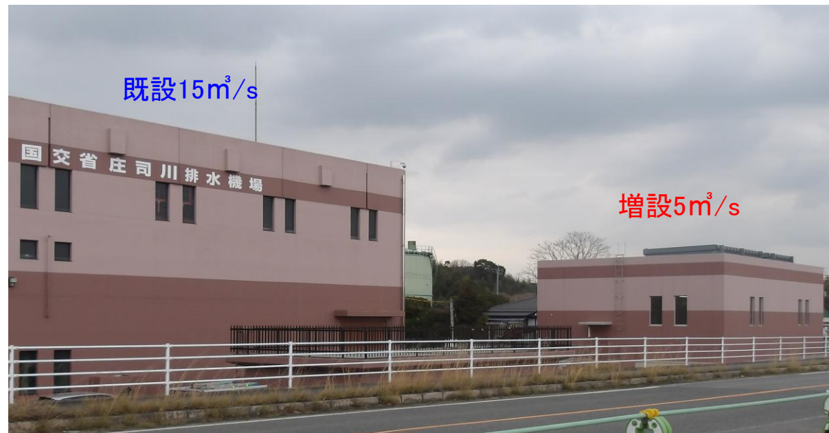
庄司川排水機場
