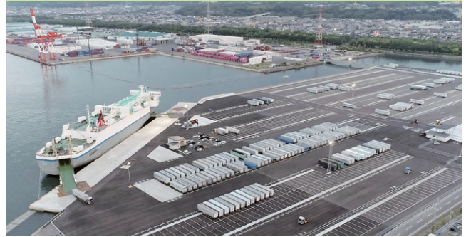
RORO船ターミナルの利用状況(大分港)
