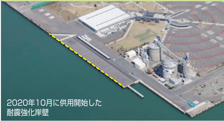
耐震強化岸壁の整備状況(八代港)
