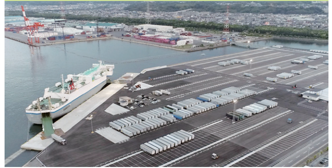
RORO船ターミナルの利用状況(大分港)
