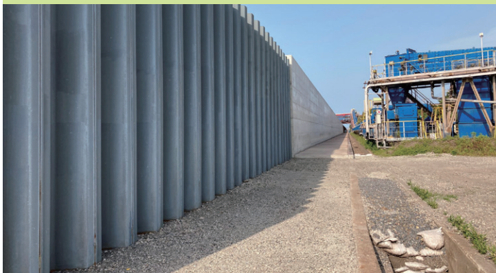
護岸整備状況(大分港海岸)
