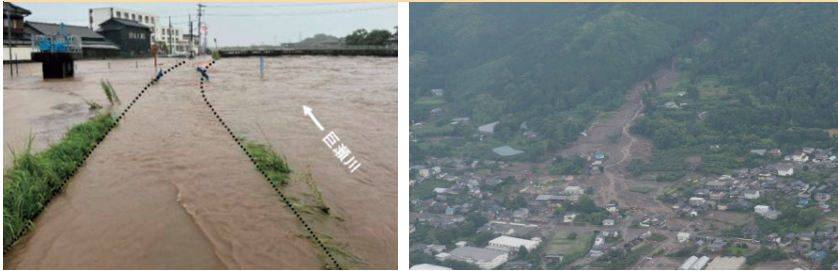
筑後川水系巨瀬川の被害状況(R5.7.10)
