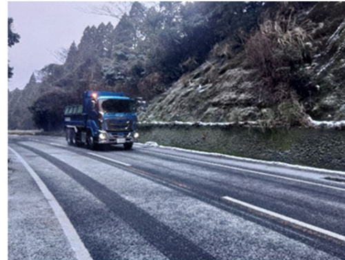
走行除雪状況
