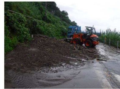
崩土撤去作業(白浜付近)
