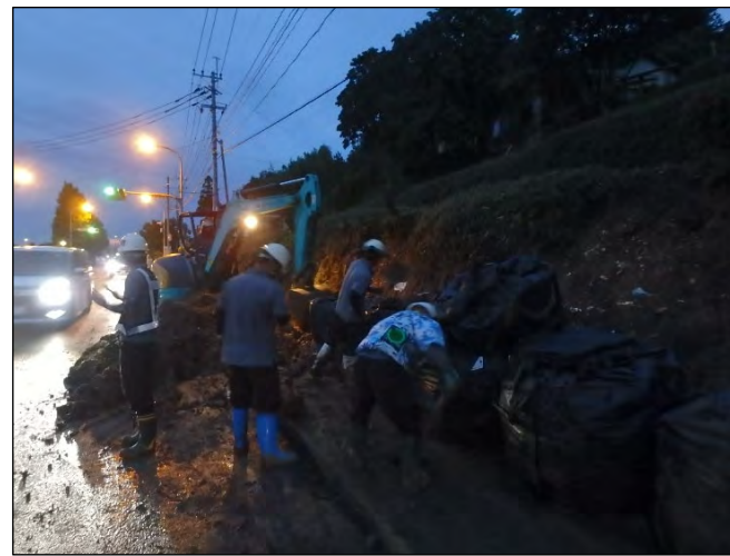
土砂撤去状況
