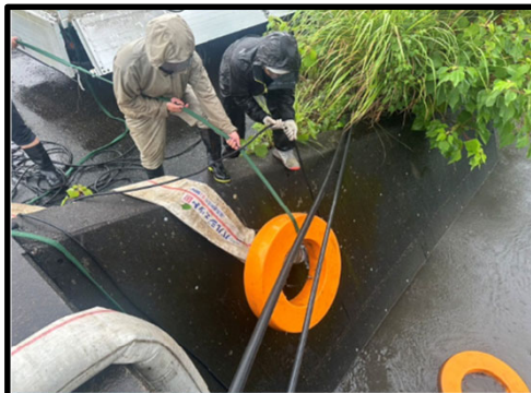
宇土市にて ポンプ設置中 (株)杉本建設
