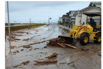
土砂等撤去作業
