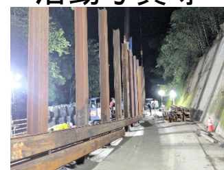
仮設防護柵設置
