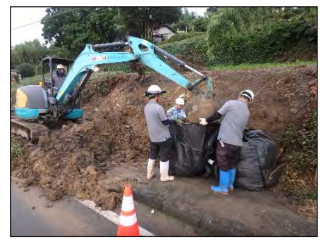
大型土のう製作
