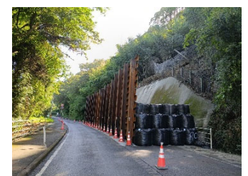
仮設防護柵設置
