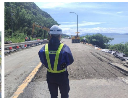
舗装復旧(路盤)
