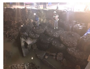
袋詰玉石、大型土のう設置
