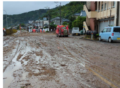
土砂撤去作業
