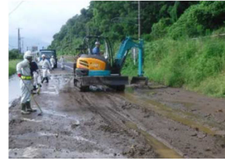
崩土撤去作業 (脇元付近)
