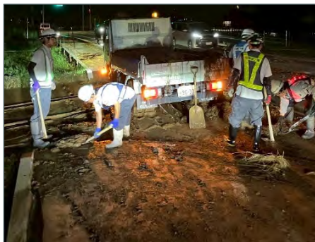
土砂撤去状況
