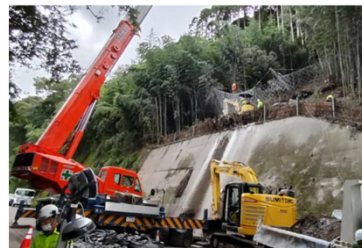
斜面崩土撤去
