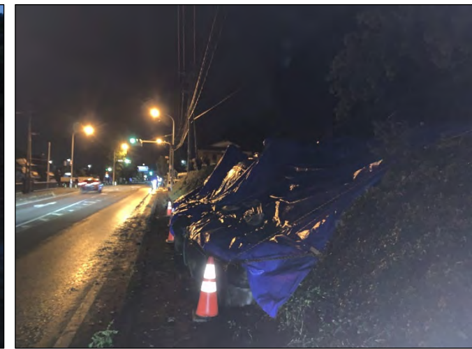
応急復旧完了
