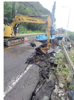
斜面崩土撤去
