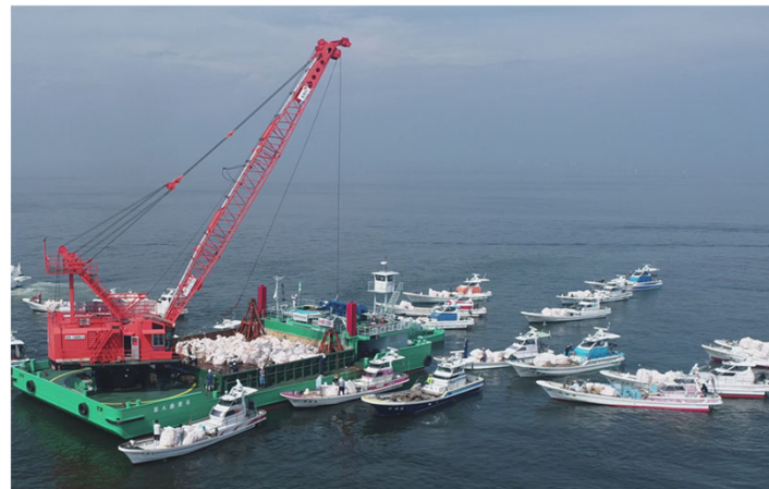
起重機船「第八勝栄号」による 回収物の受け取り状況
