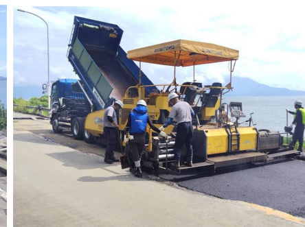
舗装復旧(As)
