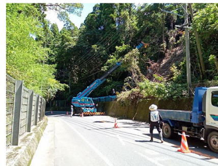
倒木・崩土撤去
