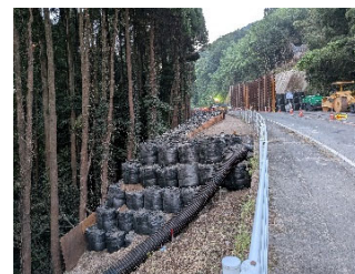
土のう設置盛土状況
