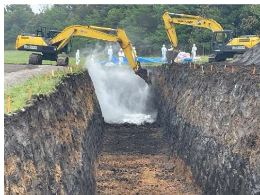
△掘削・石灰散布状況
