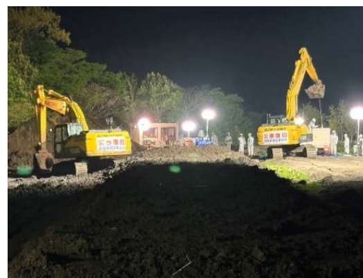
△埋却状況（夜間）
