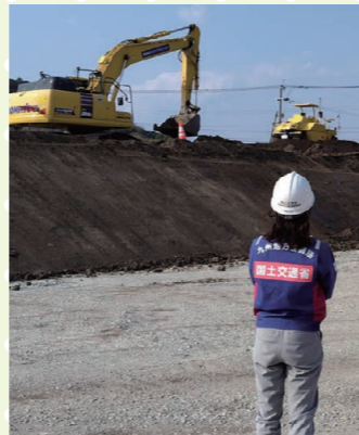
盛土工事現場の監督状況
