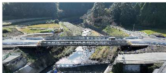
応急組立橋による交通路の確保
