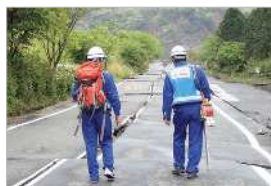
道路崩壊箇所等の調査
