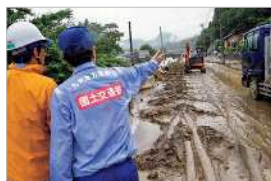
TEC-FORCEによる復旧現場の指揮監督
