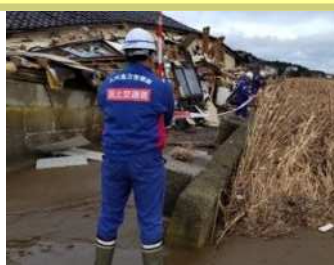
【令和6年能登半島地震】 (石川県珠洲市)
