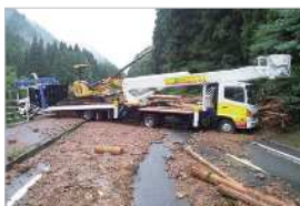
災対法に基づき車両を撤去
