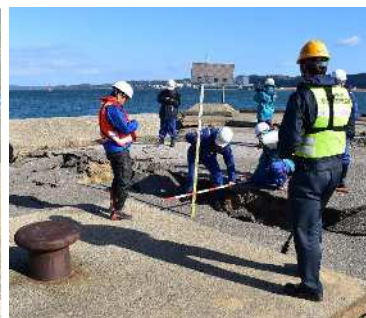
港湾被害状況の調査
