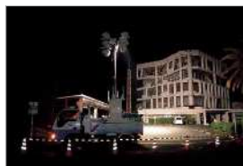
照明車の配備による夜間作業支援
