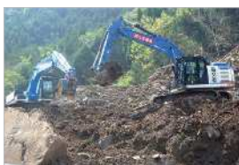
土砂撤去作業
