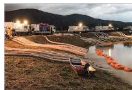
排水ポンプ車による緊急排水
