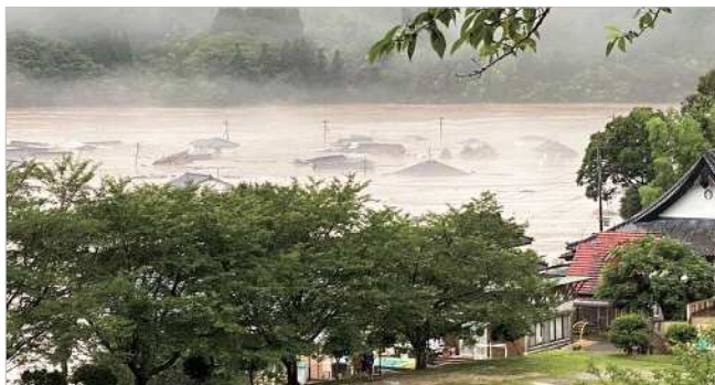
熊本県球磨村の被害(令和2年7月豪雨)
