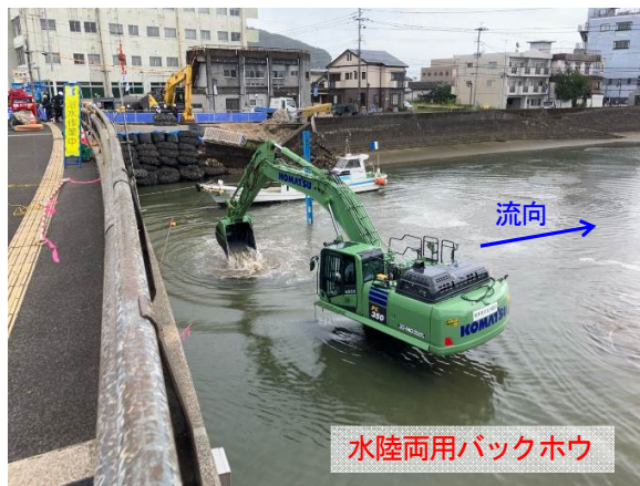
写真5 がれき撤去状況
