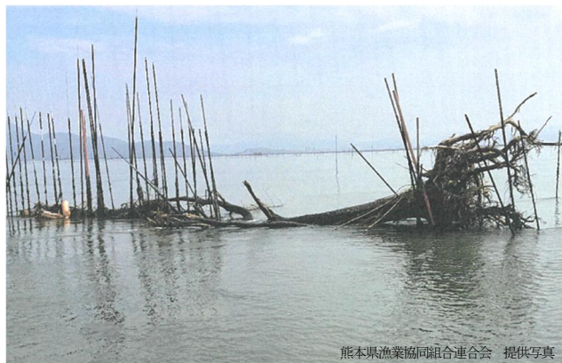
写真-3 漁業施設に被害をもたらした流木
