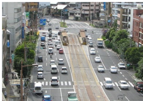
写真-2 国道34号馬町交差点（整備前状況）
