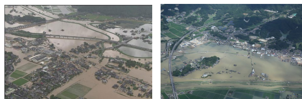
写真-1 出水の状況
