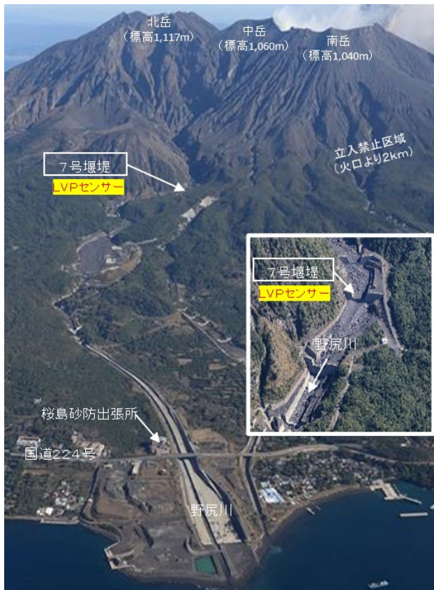
図-2 LVP センサー設置位置図（野尻川 7 号堰堤）
