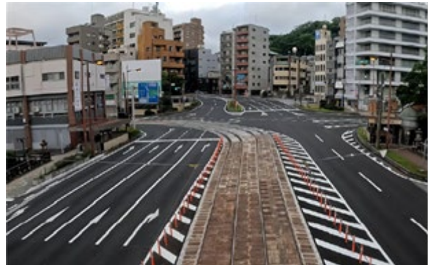
写真-6 国道34号馬町交差点4車線化状況（対策後）
