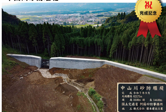
図-5 中山川砂防堰堤完成写真
