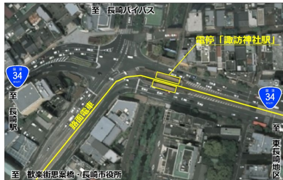
写真-1 国道34号馬町交差点付近航空写真（整備前状況）
