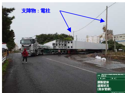
写真-4 陸上運搬状況
