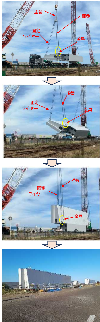
写真-7 鋼製壁体据付状況
