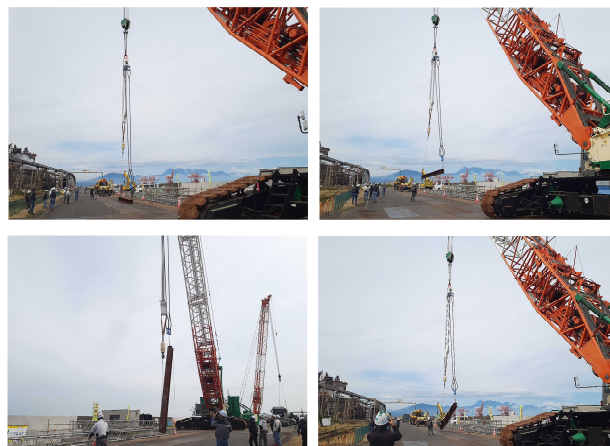
写真-5 引き起こし作業の試験施工
