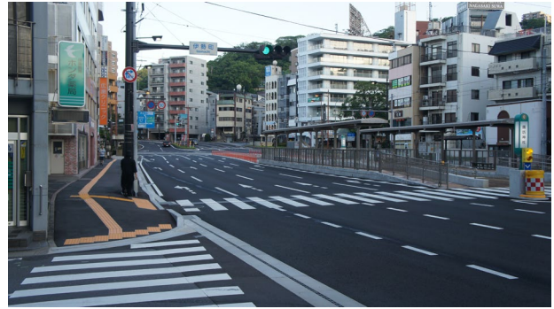
写真-5 電停「諏訪神社駅」へのアクセス状況（対策後）
