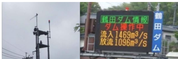
図一2 回転灯（左）と情報板（右）の写真
