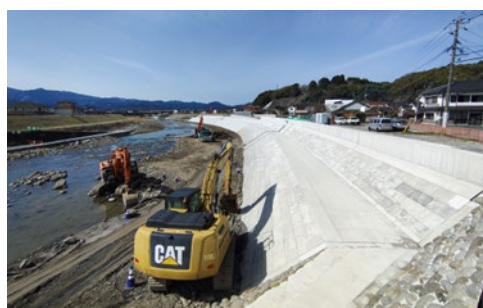
写真4 河川改修の様子(花月川右岸 3k100 付近)
