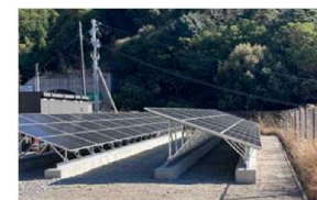
太陽光発電施設の設置
