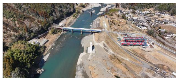
写真-3 トラッククレーンベント架設
