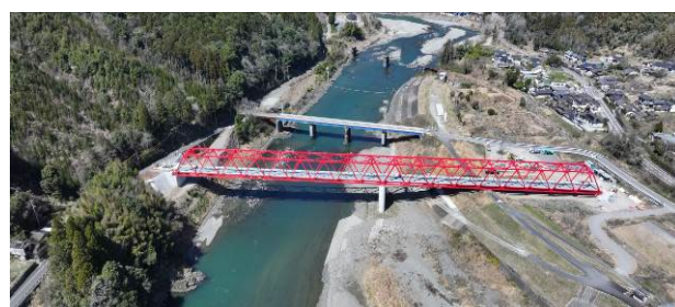
写真-5 架設完了
