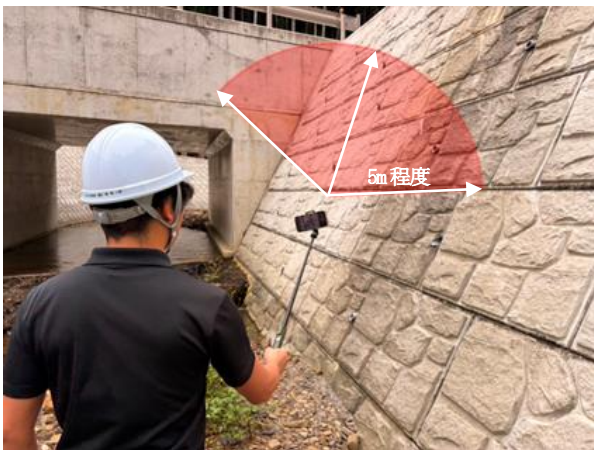
写真-4 LiDARによる点群データ取得状況
