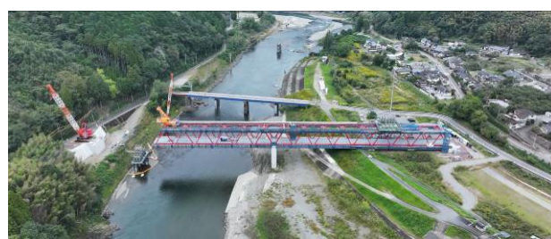
写真-4 トラバークレーン架設
