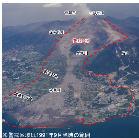
図-1 火砕流・土石流による被害を受ける水無川流域
