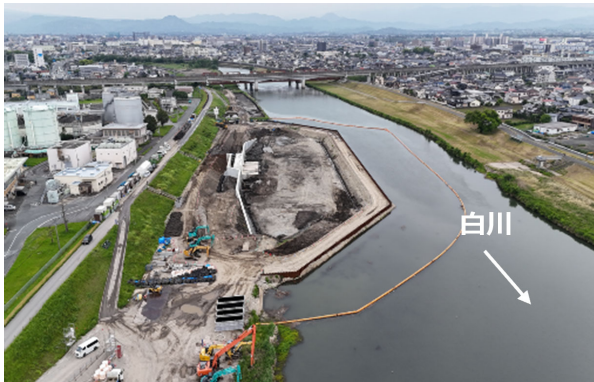
図-3 施工状況（2026/4 撮影）
