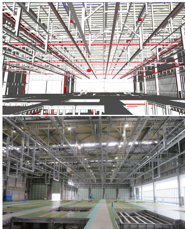
図-7 検査場内部 施工状況確認
