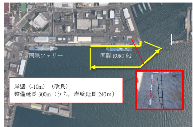
（写真-2）本港地区岸壁（-10m）改良
