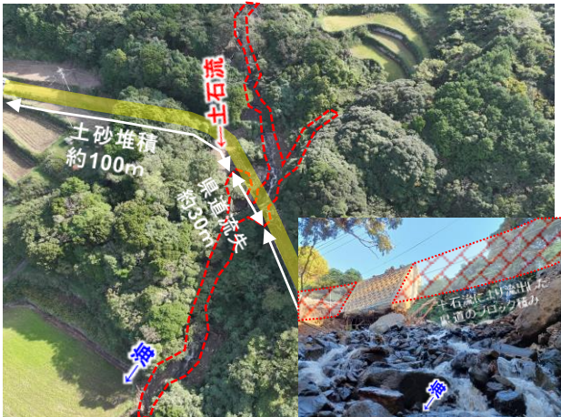
写真-1 土石流による道路崩壊 (令和6年：主要地方道平戸田平線)
