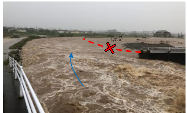
写真-2 河川堤防の決壊による氾濫 (令和2年：2級河川佐奈河内川)
