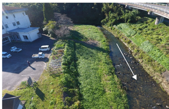
写真-6 厳木コミセンエリア写真（整備前）
