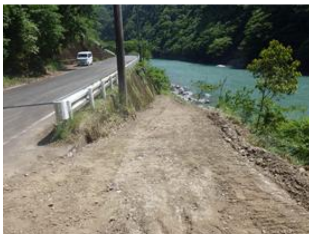
写真-7 整備後の様子
