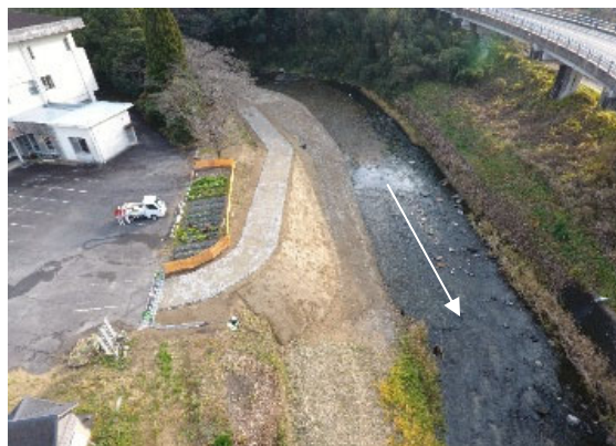
写真-7 厳木コミセンエリア写真（整備後）
