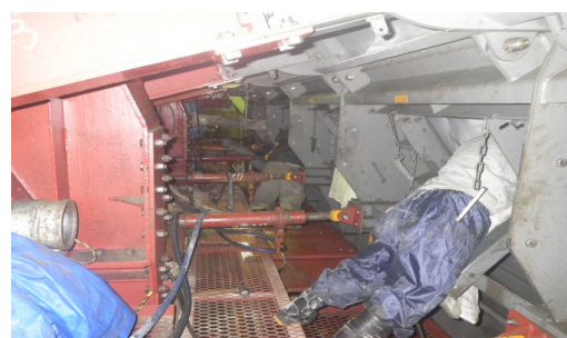
写真-5 人力での打設作業
