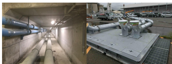
写真-12 既設配管 (埋設)
