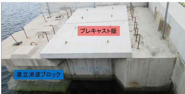
写真-9 プレキャスト版設置
