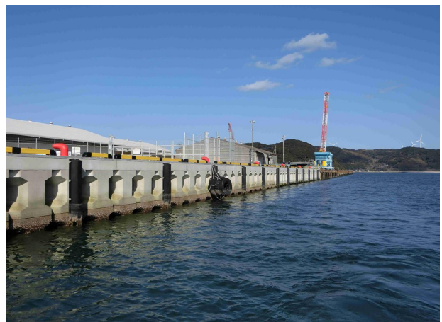
写真-19 妙見地区3号岸壁(-7.5m) 2026年4月時点
