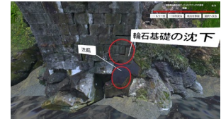
図-5 アーチ形状の変状が生じている状態と不可視部の洗掘のメカニズム
