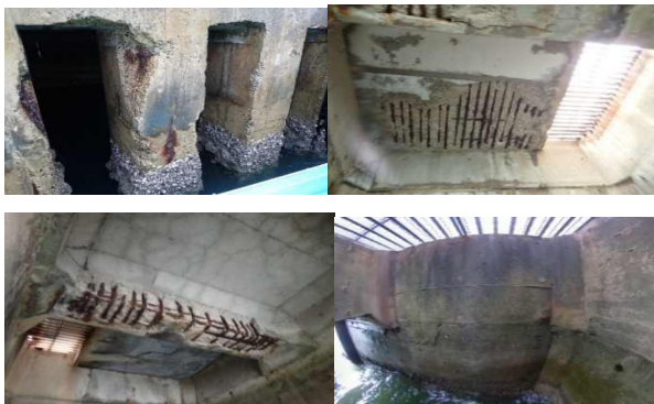
写真-3 状況写真 (スリット部、梁、壁、頂部)
