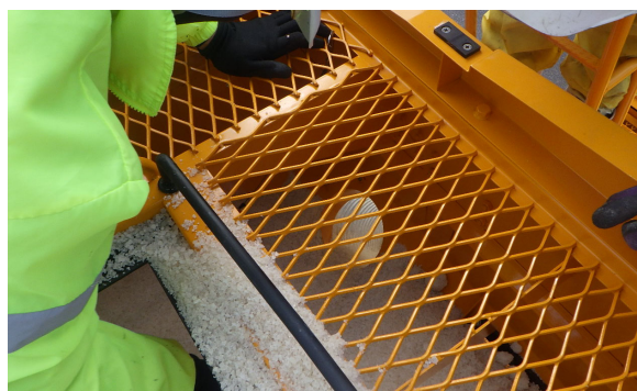
写真－7 ホッパーへの投入状況
