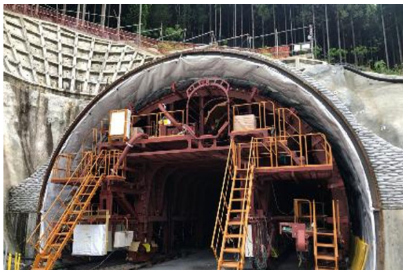
写真-10 移動式自動型枠
