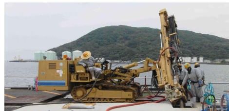
写真-5 グラウンドアンカー工
