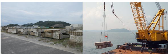
写真-16 撤去材仮置き
