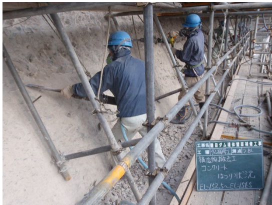
図-7 はつり作業の状況
