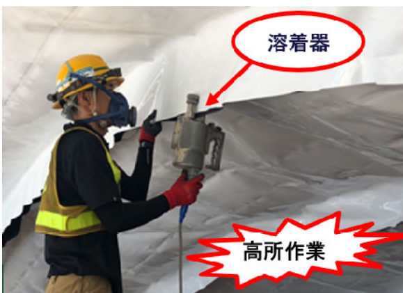
写真-2 手動による溶着作業
