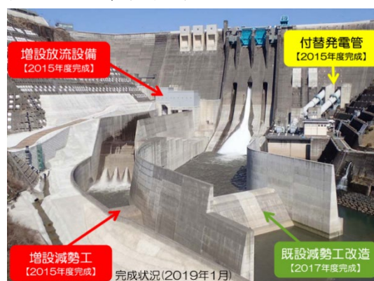
図-1 鶴田ダム再開発工事の概要
