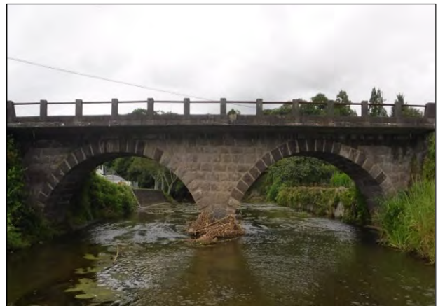
写真-1 石橋（石造アーチ橋）
