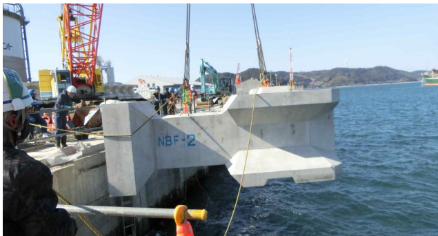
写真-8 直立消波ブロック据付
