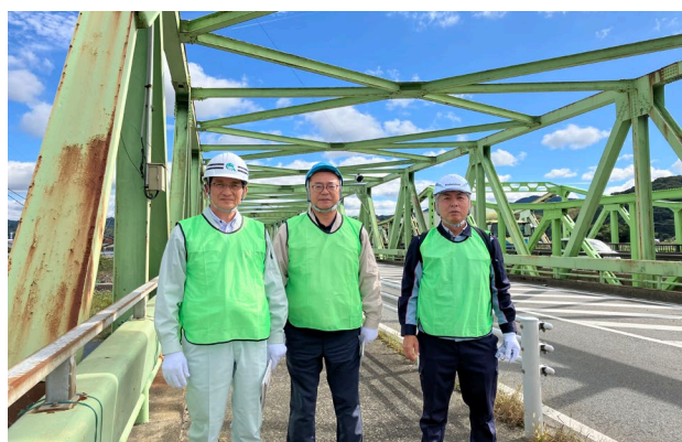
写真-5 福岡橋守マイスターによる自主点検状況
