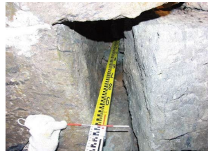
写真-2 洗掘と空洞
