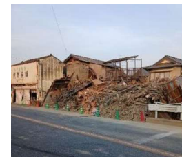
八代鏡宇土線（八代市） 倒壊建築物
