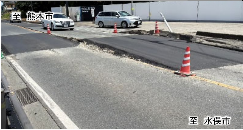
応急復旧状況
