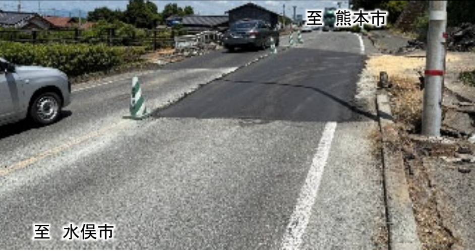
応急復旧状況
