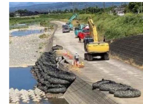
氷川（氷川町）応急工事
