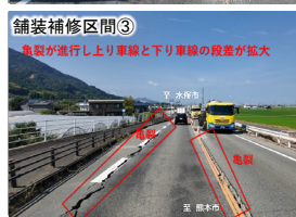
▲路面補修による平坦性確保の取組（熊本河川国道事務所）
