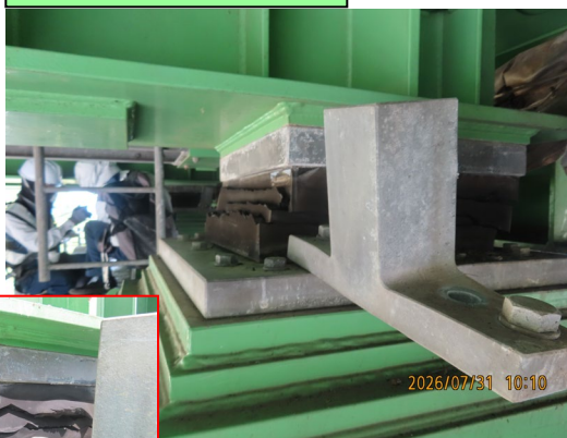
②被災状況（支承部破損）
