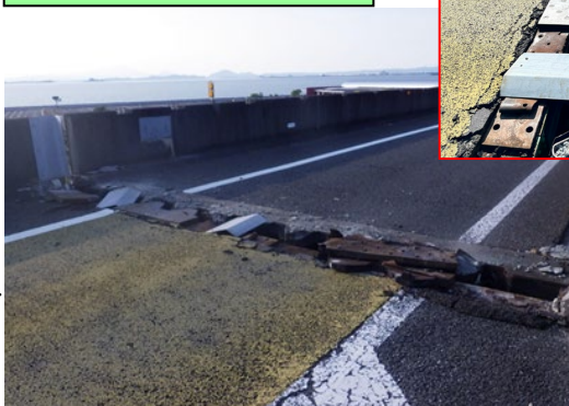
②被災状況（支承部破損）
