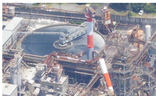
▲ 日本製紙煙突崩壊を防災ヘリ「はるかぜ」より撮影
