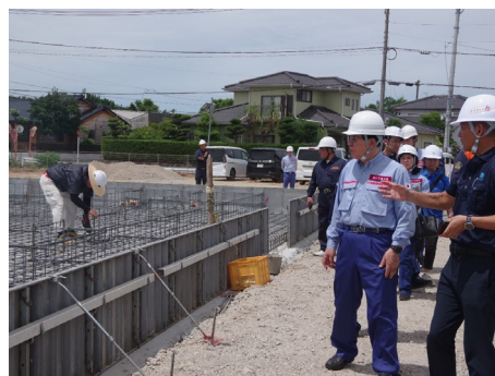
▲仮設住宅建設箇所
