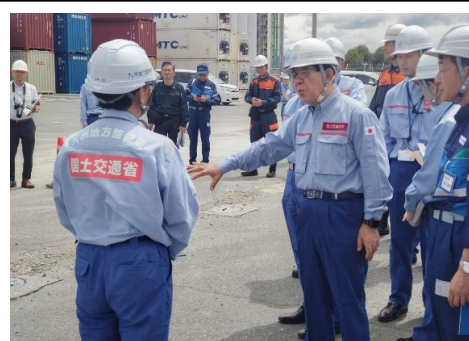
▲八代港被災箇所
