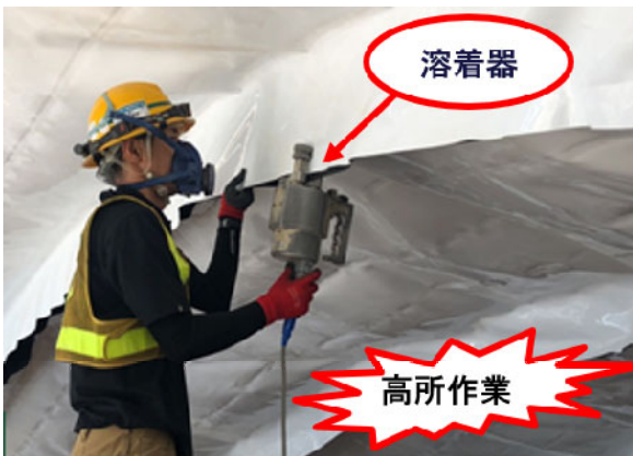
写真-2 手動による溶着作業
