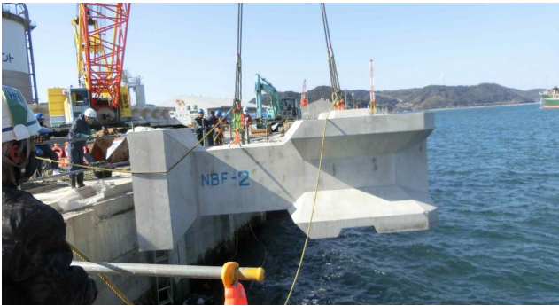
写真-8 直立消波ブロック据付
