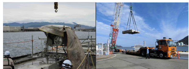
写真-6 ワイヤソー切断 写真-7 既設部材撤去
