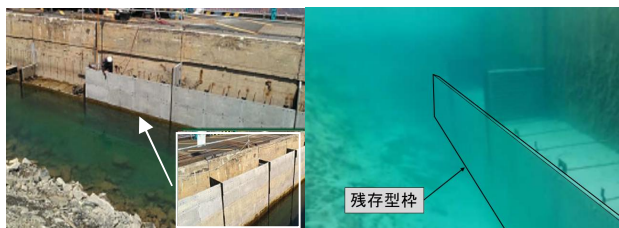
写真-18 残存型枠
