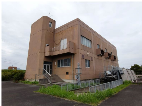
図-1 内田川排水機場 外観
