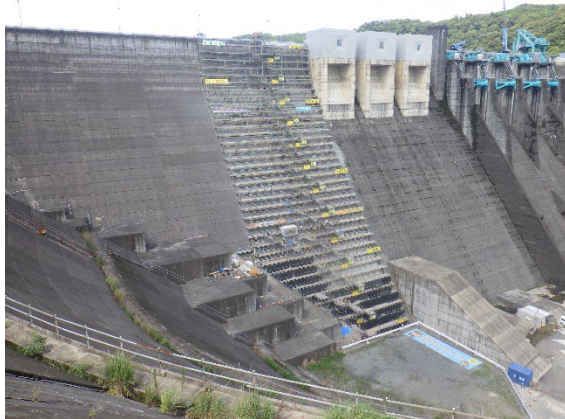
図-6 全足場の状況
