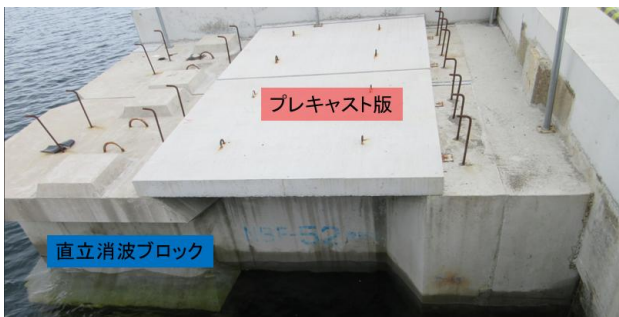
写真-9 プレキャスト版設置
