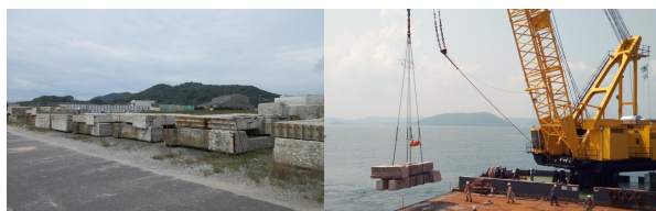
写真-16 撤去材仮置き
