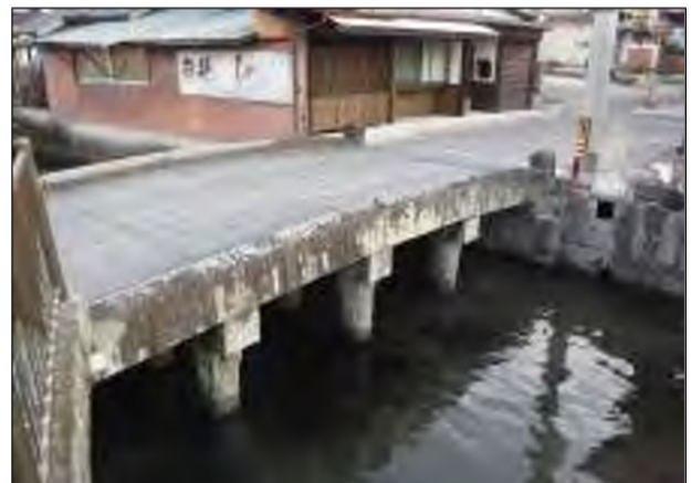
写真-2 石橋（石桁橋）
