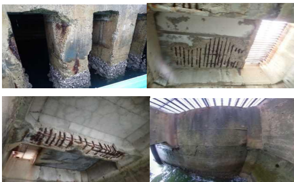
写真-3 状況写真 (スリット部、梁、壁、頂部)
