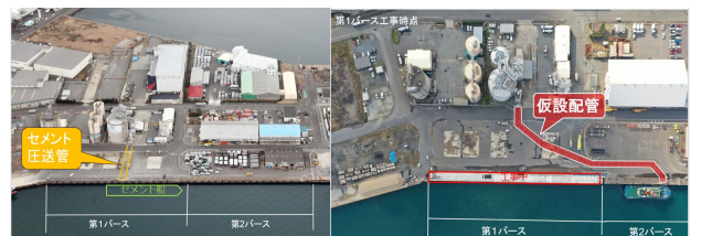
写真-14 改良前利用状況
