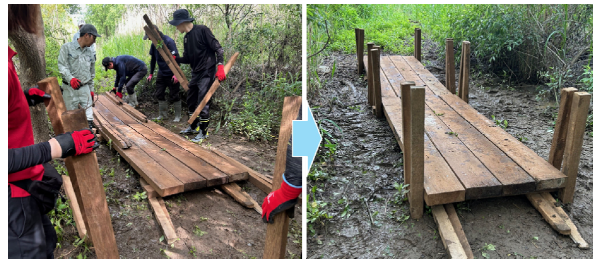
写真-8 散策路の整備
