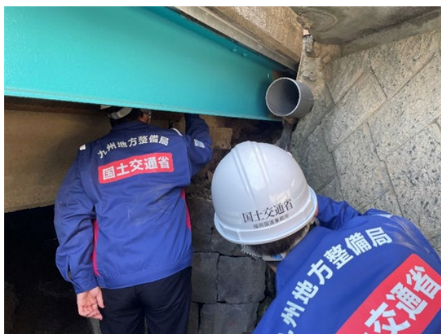
写真-3 点検実習状況
