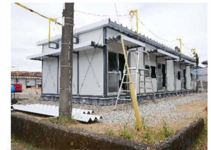
氷川町吉本団地（軽量鉄骨造・平屋）現場状況写真
