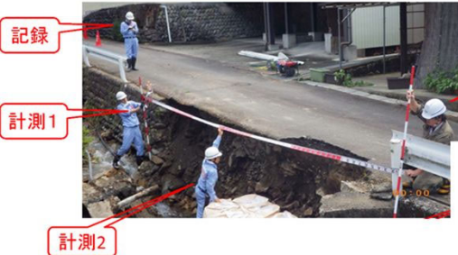
▲被災状況調査班による計測状況
