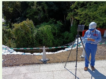
▲レーザースキャナー計測状況
