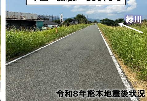
今回 舗装／変状なし
