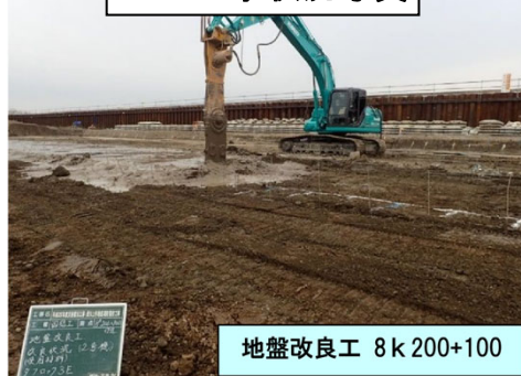
H28工事状況写真
