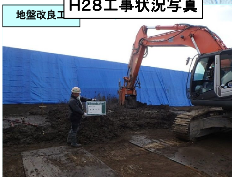
H28工事状況写真
