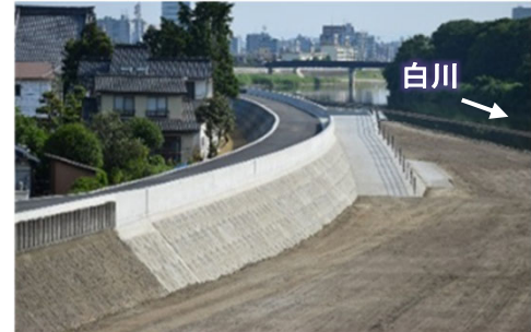
H28復旧完了写真
