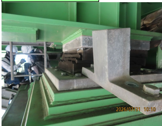
②被災状況（支承部破損）
