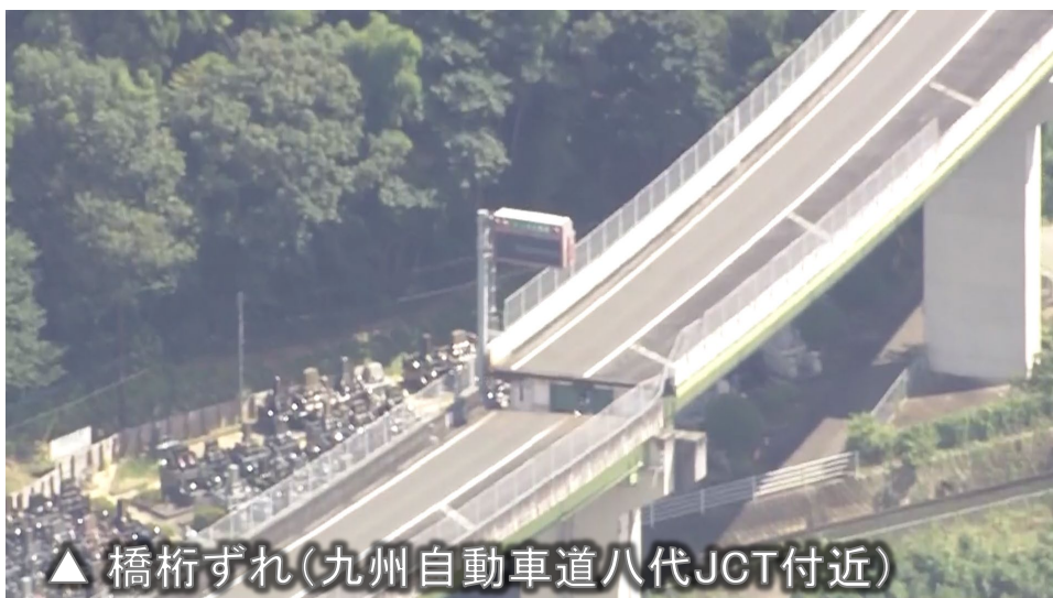
▲ 路面ずれ(九州自動車道八代IC付近)
