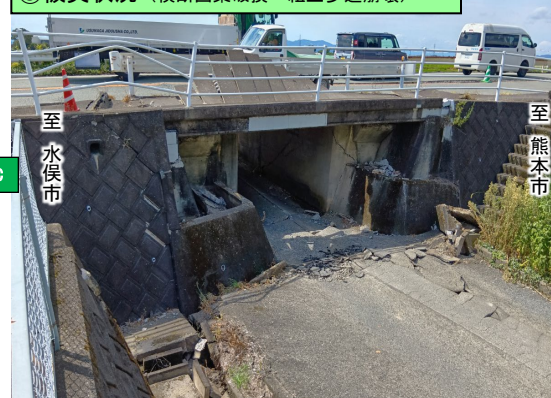
③被災状況（横断函渠破損・組立歩道崩壊）
