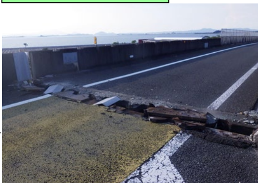
②被災状況（支承部破損）
