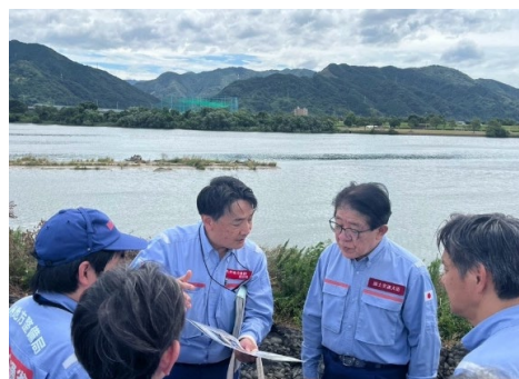
▲球磨川堤防被災箇所
