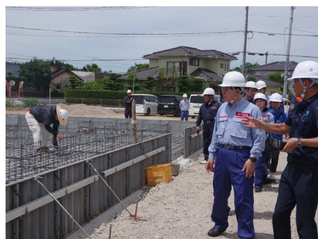
▲仮設住宅建設箇所
