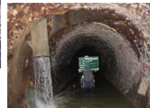
化学的弱部(腐食のおそれ大きい箇所)における事例
