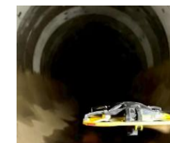
ドローンによる目視調査
