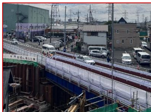
暫定2車線での供用開始(4/15撮影)
