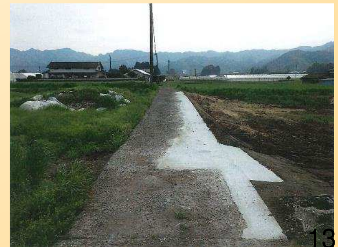
舗装修繕工事 400,000円交付
