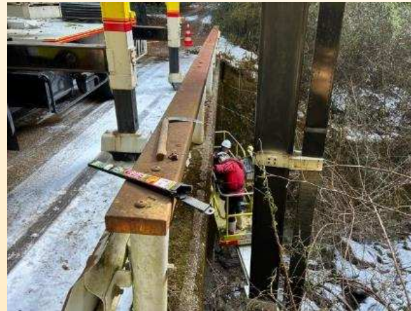
橋梁点検状況
