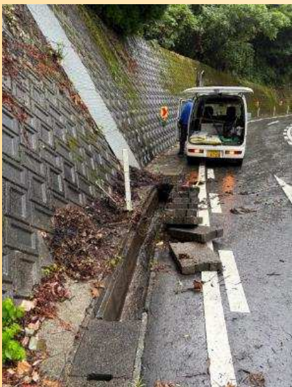
土砂上げ状況
