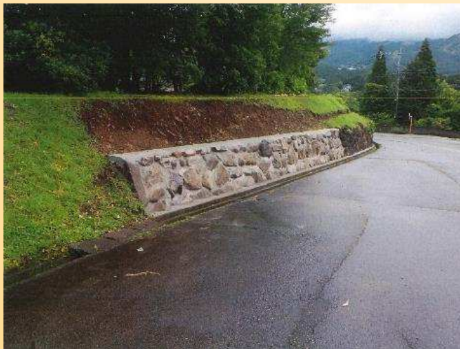
法面改修工事 400,000円交付
