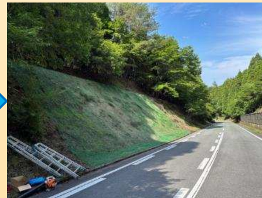
落石防護ネット貼付
