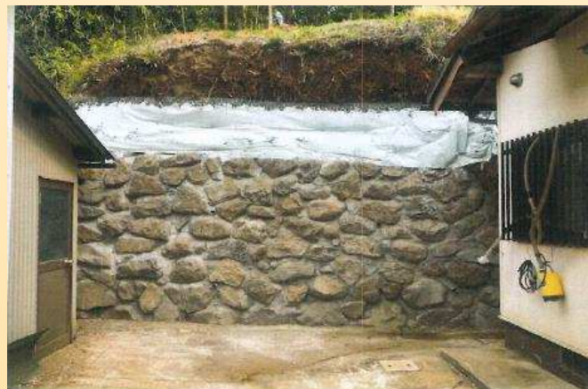
法面改修工事 400,000円交付
